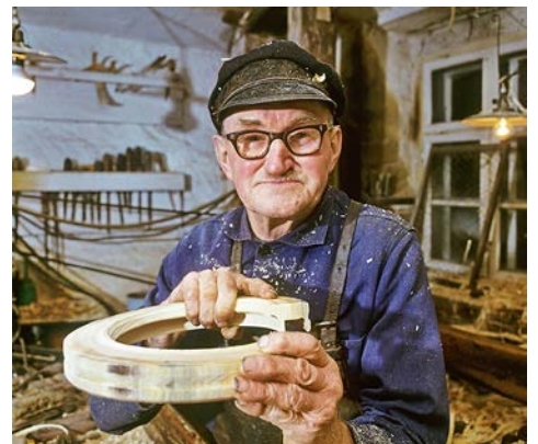
Reifendreher, 1971. Beim Reifendrehen wird erst ein Profilring gedreht und dieser dann in Abschnitte zersägt
